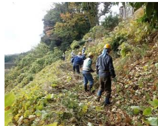
斜面地の人力による除草作業
