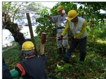
モーガン邸でのフェンスの修理
