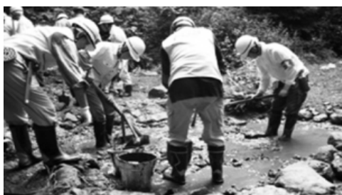
西富憩いの森ビオトープ池補修
