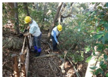
松が岡5丁目緑地での散策路整備
